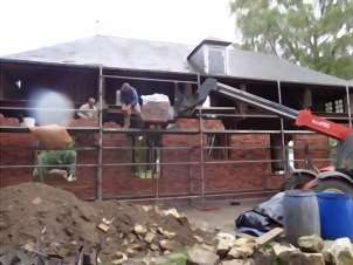
Mi-septembre : reconstruction de la façade arrière en brique.
